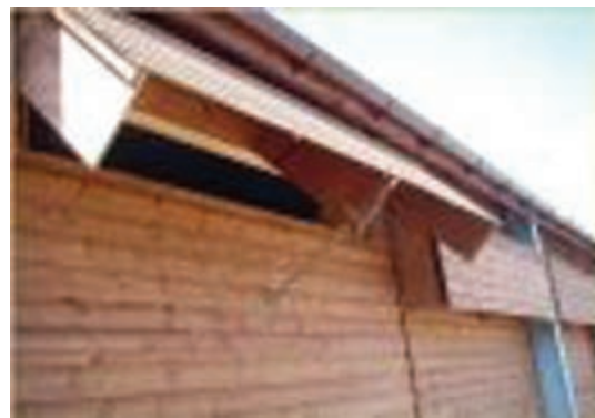
تصویر ۲-۱۴ - انواع دریچه‌های ورود هوا
