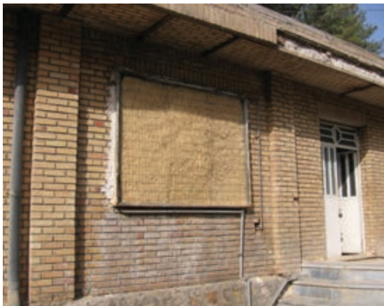
تصویر ۱۳-۲- انواع سیستم پوشال و هواکش
